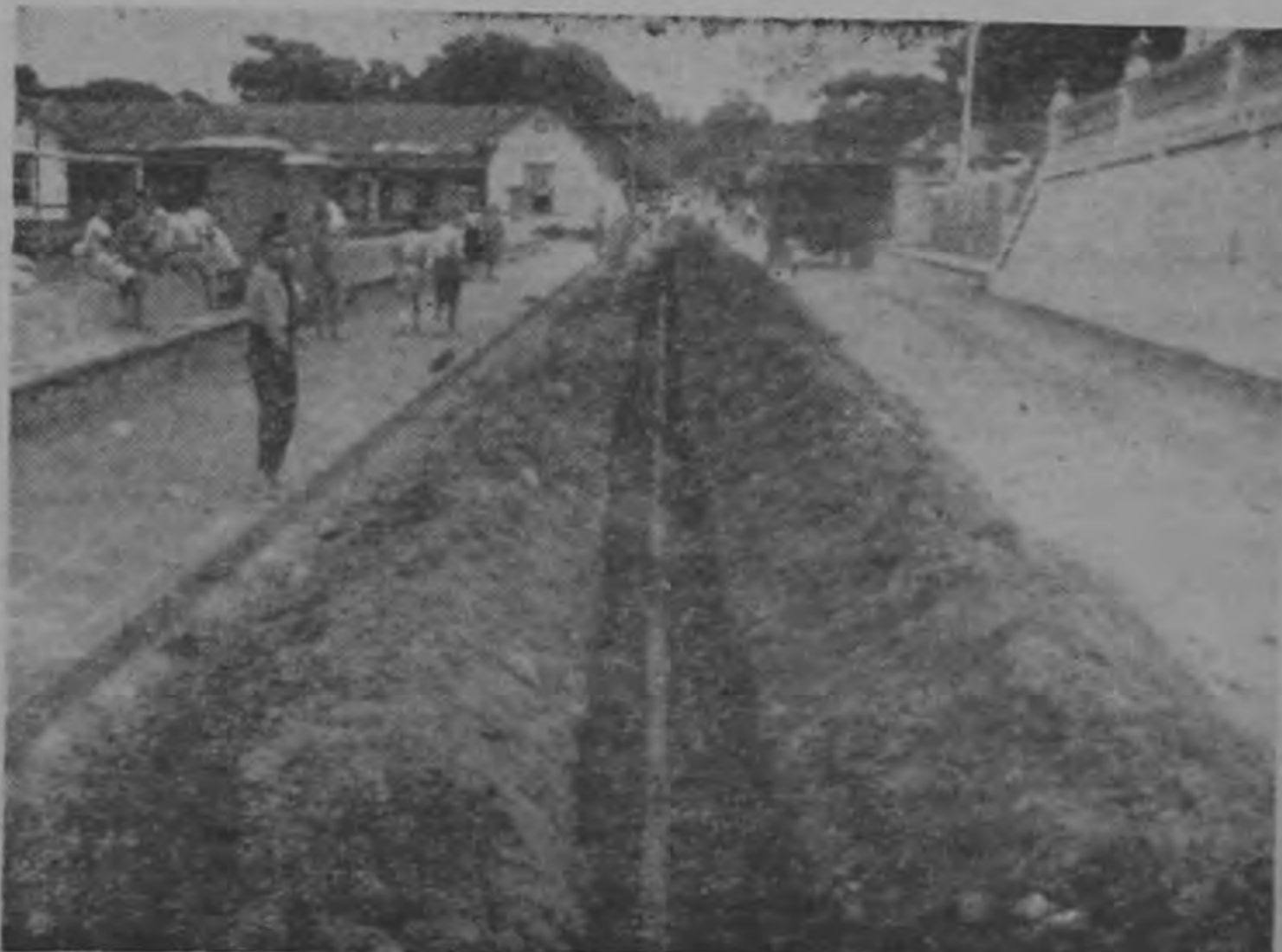
Los impuestos que paga el pueblo se invierten ahora honesta y eficientemente en la construcción de carreteras.
